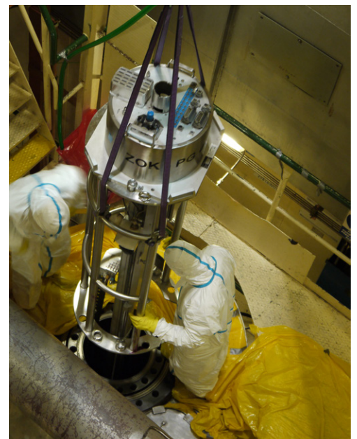
Práce při odstávce 2. výrobního bloku
